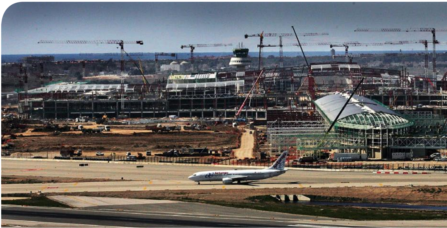
Al fondo, antigua Torre de Control de Barcelona, hoy en desuso, entre las obras de la nueva Terminal Sur.
