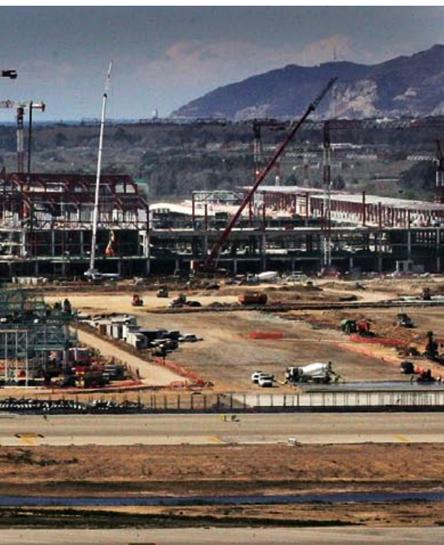
Fuente: Aeropuerto de Barcelona
